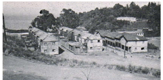
Foto 8: Nuevas viviendas para obreros de 1940 construidas en material sólido después del terremoto de 1939. Noviembre 1983.
